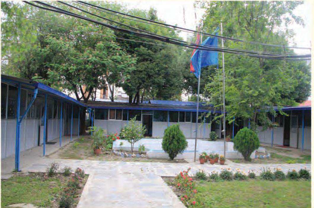
भूकम्पबाट कार्यालय क्षतिग्रस्त भएपश्चात् टहरा निर्माण गरी सञ्चालनमा रहेको आयोगको कार्यालय ।
